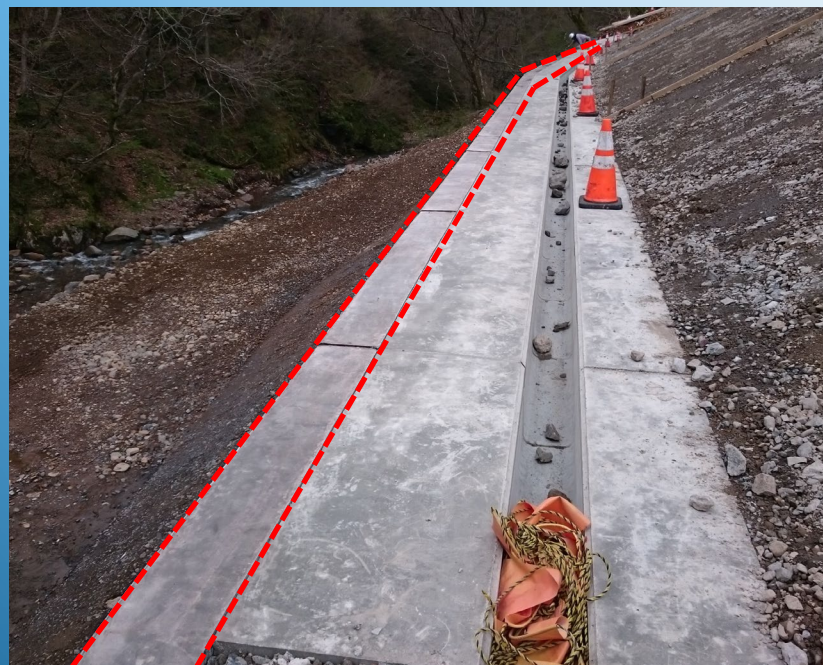
IZW.Guard塗布後の状況
