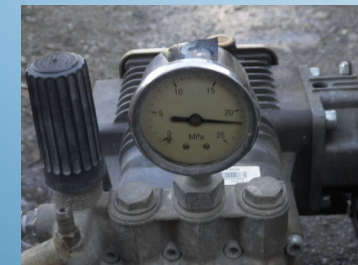
高圧洗浄の状況
