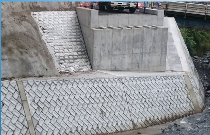
現場透水量試験箇所
