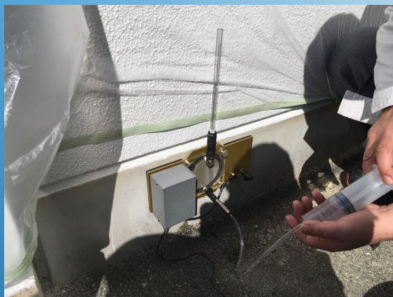
塗布前の現場透水量試験
