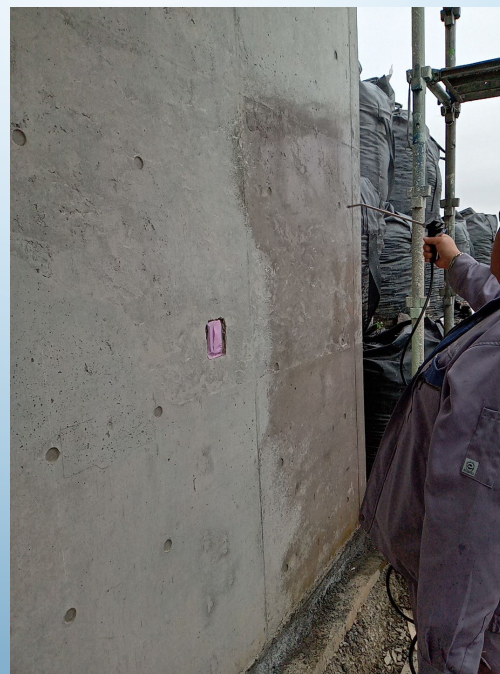
IZW.Guard塗布後の状況
