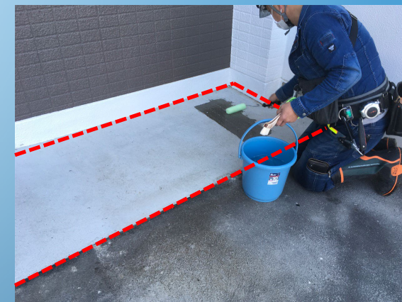
IZW.Shield 塗布状況(翌日)
