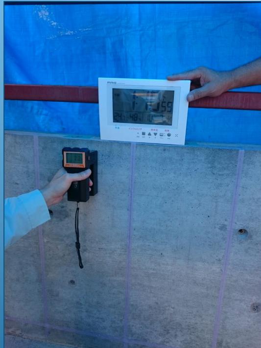
含水率測定状況
